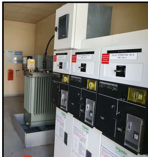
Photos des cellules HT avec le transformateur 250kVA existant
