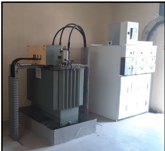
Photos des cellules HT avec le transformateur 250kVA existant
