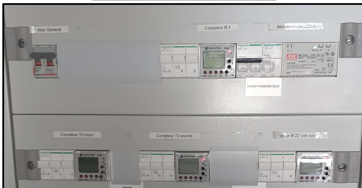
Détail face avant avec transmission de données via une antenne LORA
